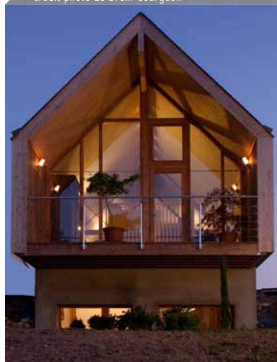
Maison «Longue Vue», Architecte : Atelier Redon Viot Liddell, photographe Clément Darrasse
