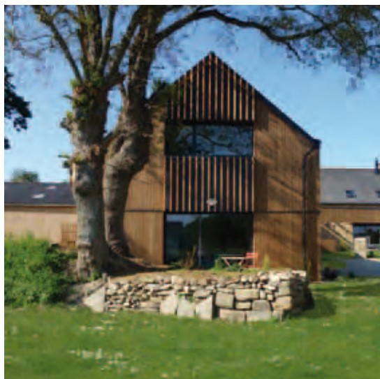
Ferm'h à Baden (56), Architecte ADAO Architecture & Gérard Lucas, Entreprise Burban Rémy
