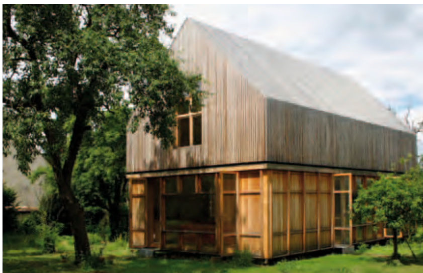
La maison dans le jardin à Veneux les Sablons (77), Architecte Arba, Entreprise Duhamel
