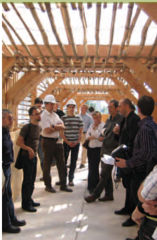
Visite de chantier, credit photo Atanbois.
