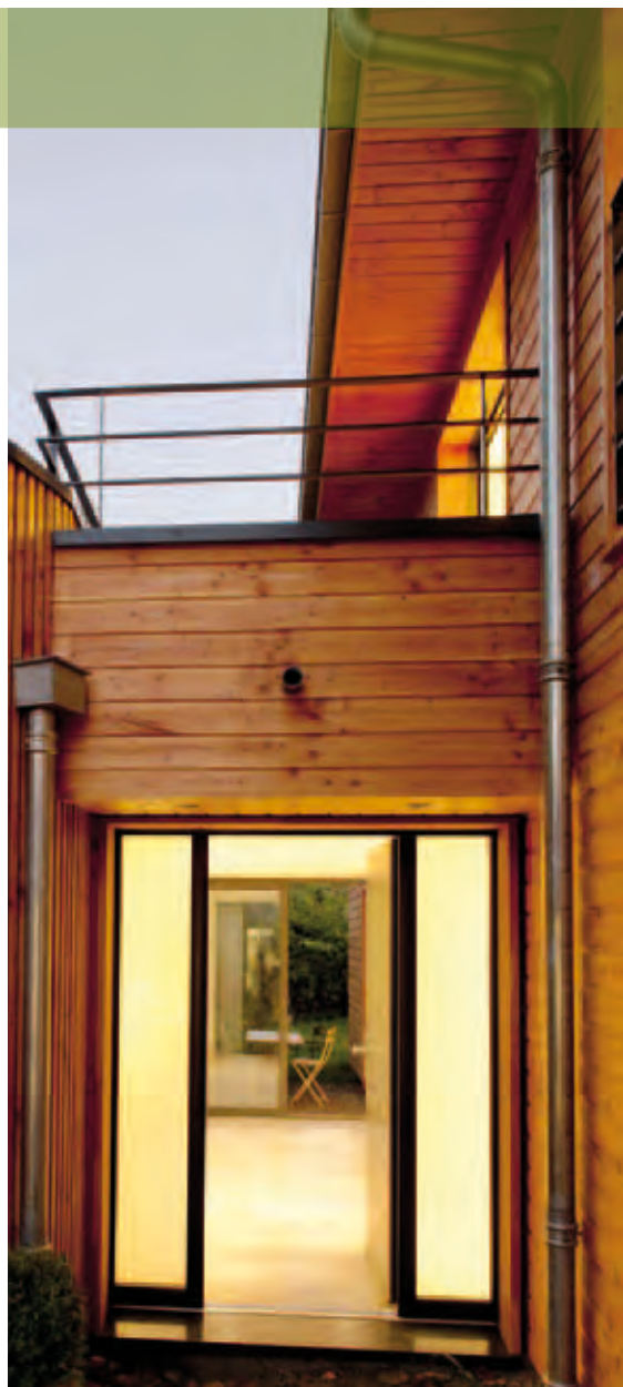
Maison Alinéa , Architecture et Bois, photographe Denis Svartz
